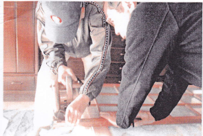
「三苦宮繕おたすけ隊」活動中の現場写真
